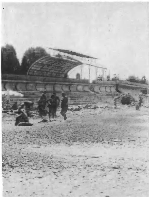
Тот же участок в июне 1983 г. после энергичных отсыпок песчано-галечного материала.
